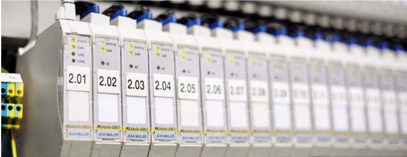
PLVario, das modulare System zur elektronischen Messdatenerfassung und -aufzeichnung, bringt mehr Transparenz in den Betrieb von Niederspannungsanlagen.
